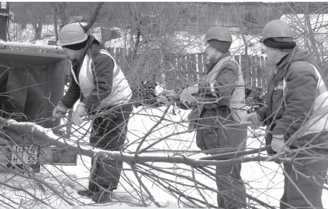
Работа бригады по обслуживанию воздушных линий Боровичского филиала. «Мульчер» измельчает спиленные деревья
