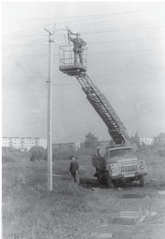
Ремонт воздушных линий электропередачи
