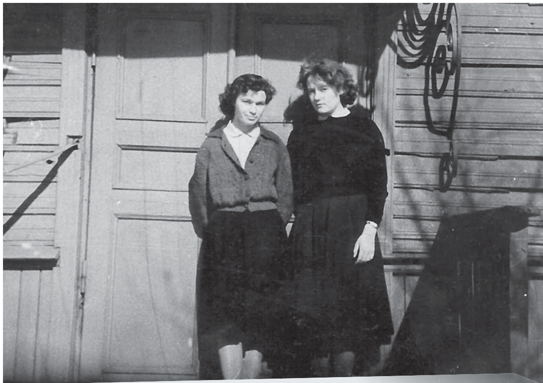
У здания электросети на Комсомольской, 10
